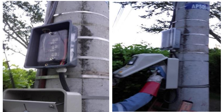
Fig. 4. Dispositivo para cambio de macro medidor, sin apertura de transformador.
