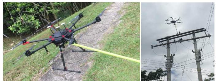
Fig. 3. Instalación Dron con Pinza sensor Link
