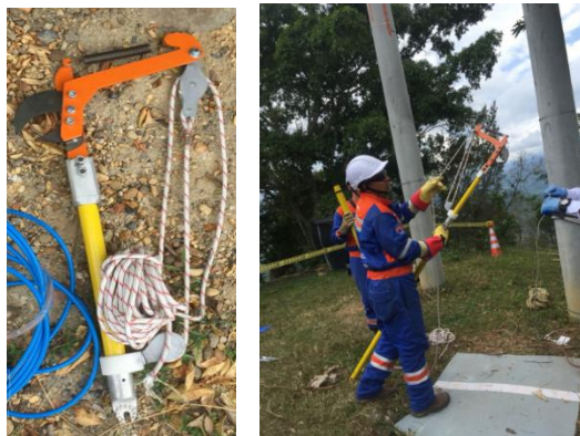
Fig. 9. Equipo para corte de Acometidas.
